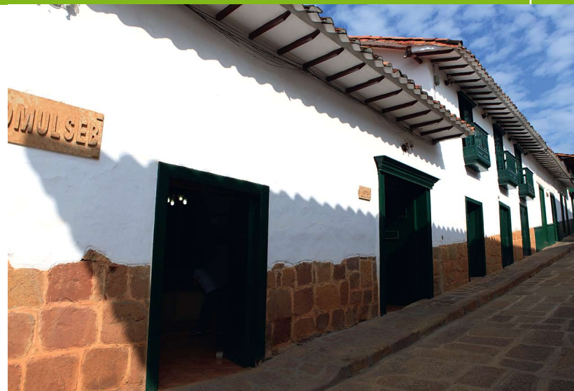
Arquitectura colonial en Barichara
