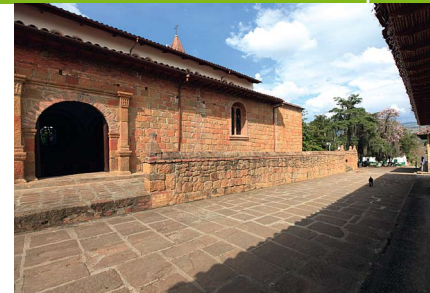
Costado de la Iglesia de Páramo
